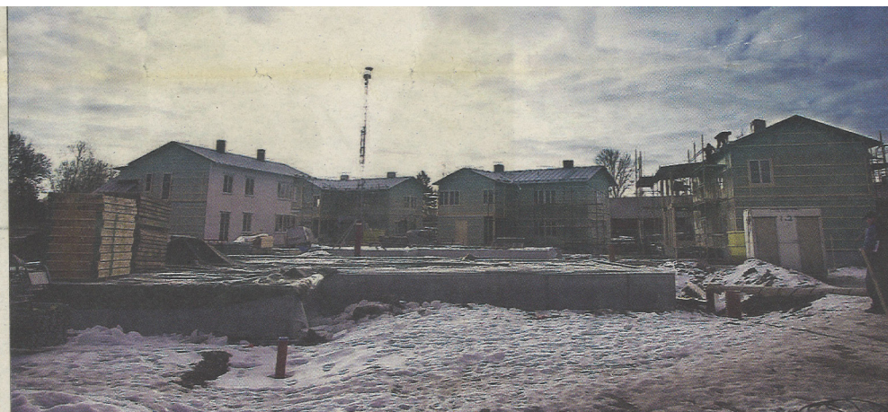
De nya lägenheterna på rökerietomten är snart slutsålda. På bygget är det bråda dagar för att hinna klart.
